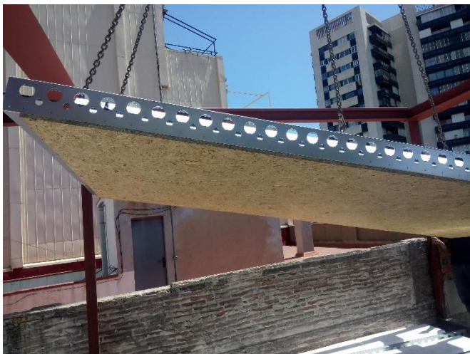
Figura 4.2: Manipulació de prellosa del sistema SES™.
