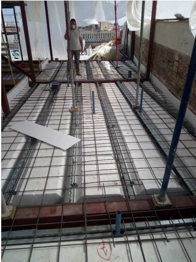
Figura 7.4: Disposició d'armadures a les prelloses.
