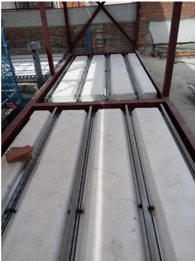
Figura 7.2: Prelloses recolzades permanentment sobre estructura metàl·lica.
