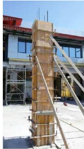
Figura 6.2: Encofrado de un pilar.
