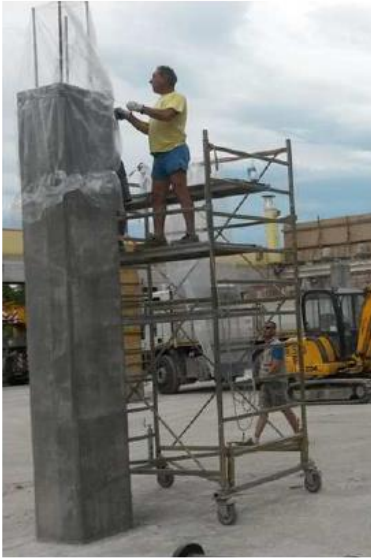
Figura 6.3: Desencofrado y protección de pilar.
