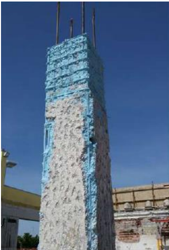
Figura 6.1: Preparación de la superficie.
