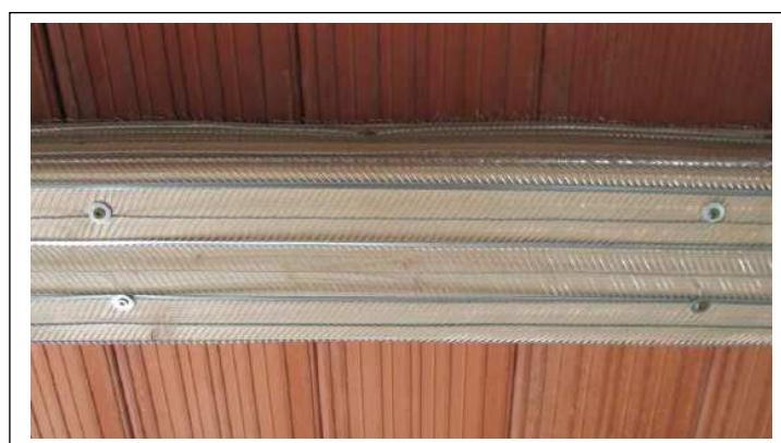
Figure A.7.3: Détail de la fixation de la maille.
