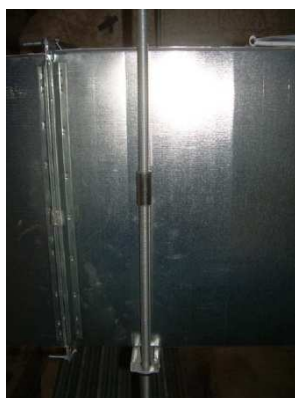
Figura A.6.1: Sistema de suspensión del conducto y junta transversal METU-System.
