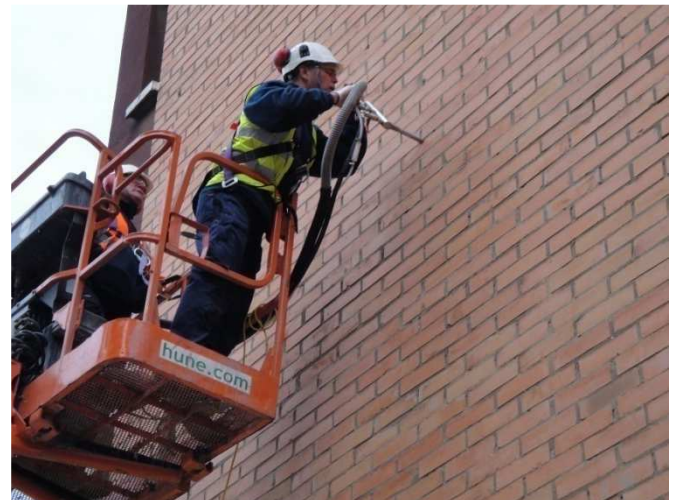
Figura 6.2: Inyección del sistema ThermaBead®.
