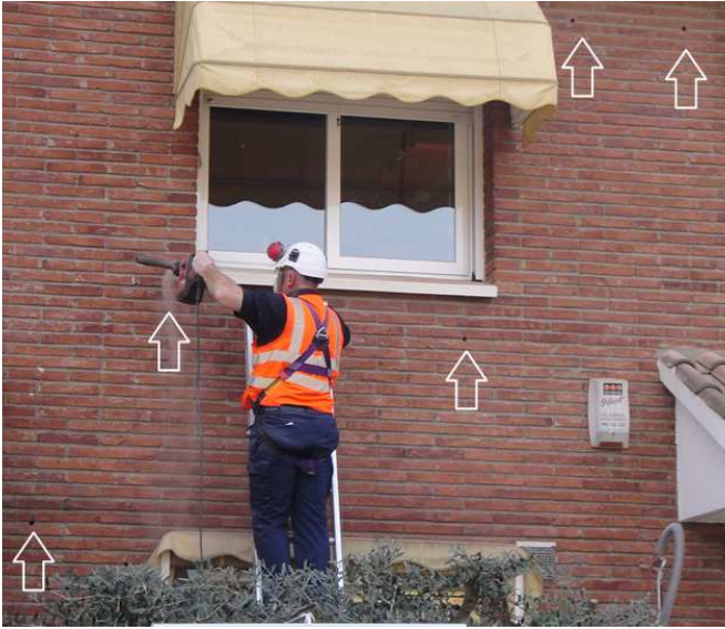
Figura 6.1: Perforación de la fachada según el patrón establecido.
